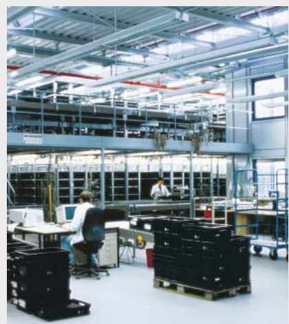
Exaktes Arbeiten wird durch die neutralweiße Lichtfarbe 940 mit bester Farbwiedergabe ermöglicht.
